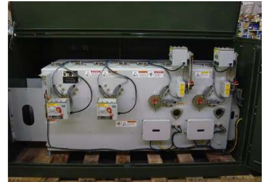
T Switch de Interrupción de Carga con puesta a tierra Integral
